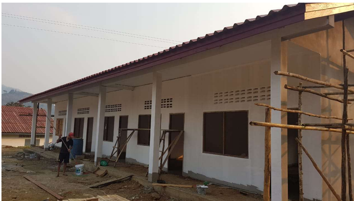
Chantier le 4 mars
