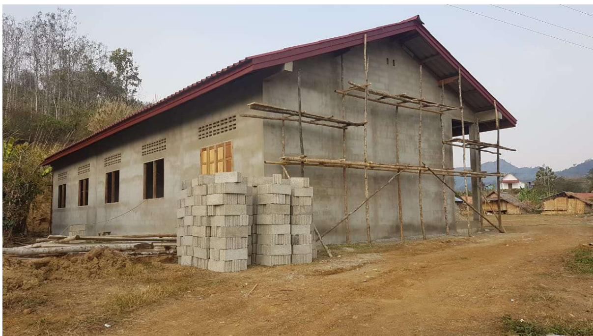
Chantier le 8 février
