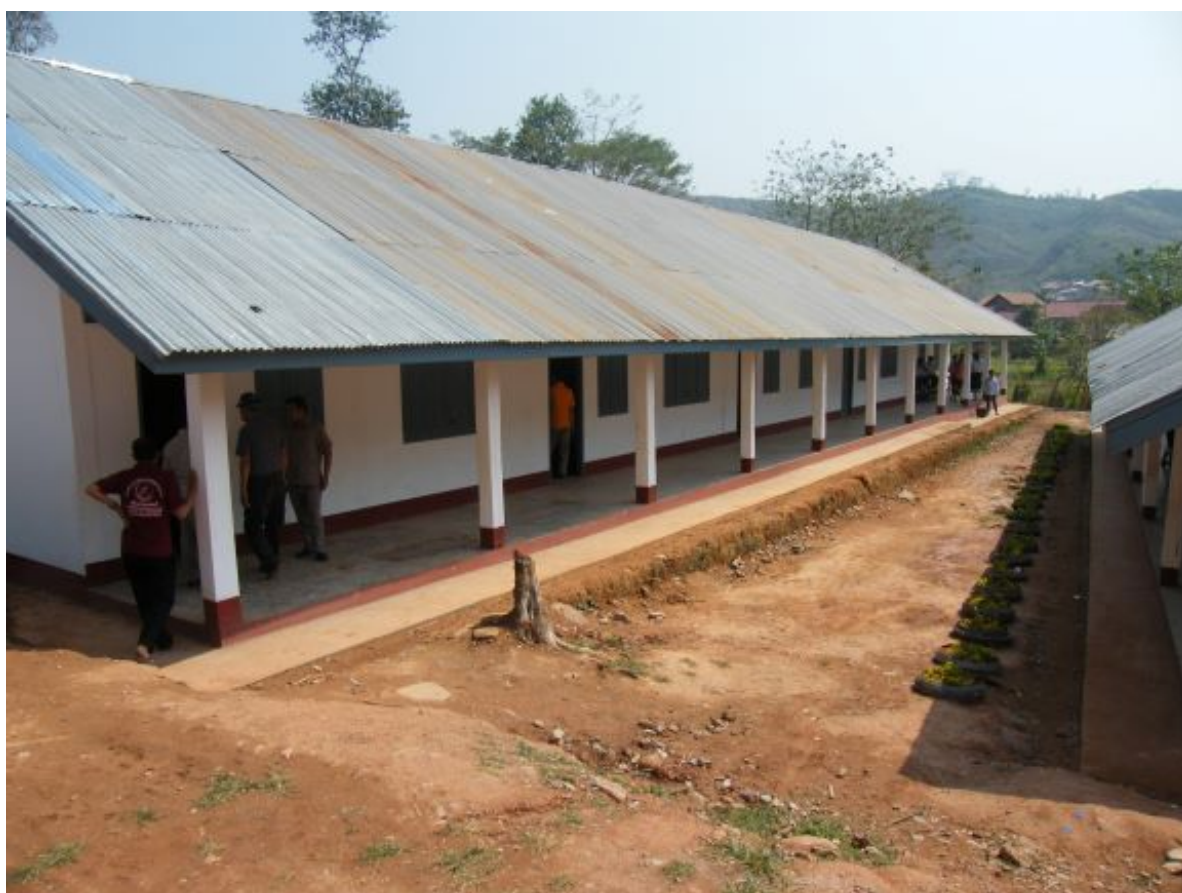
Voici le bâtiment après sa rénovation
