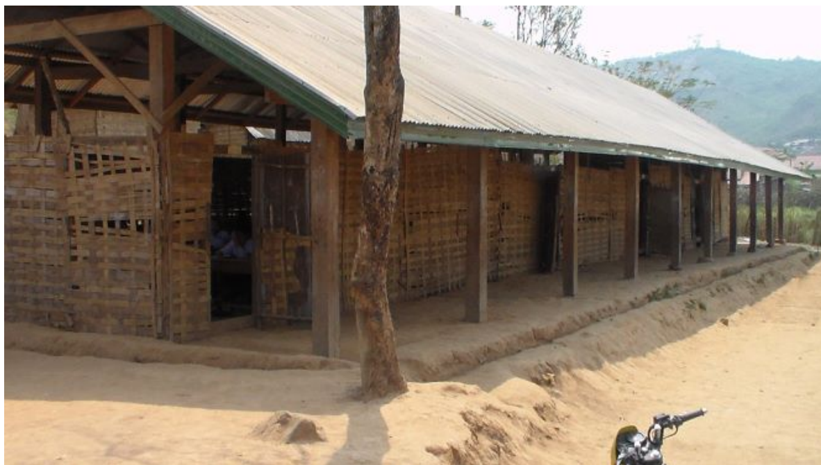
Voici le bâtiment avant sa rénovation
