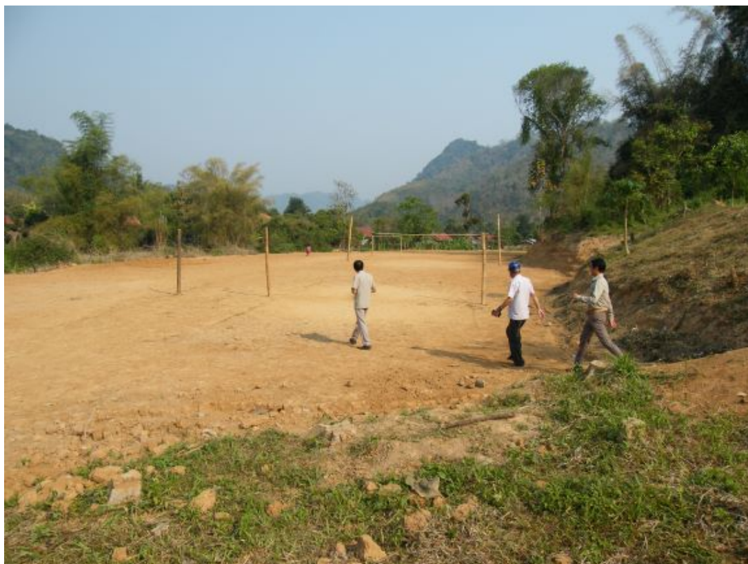
L'aire de sport après les travaux
