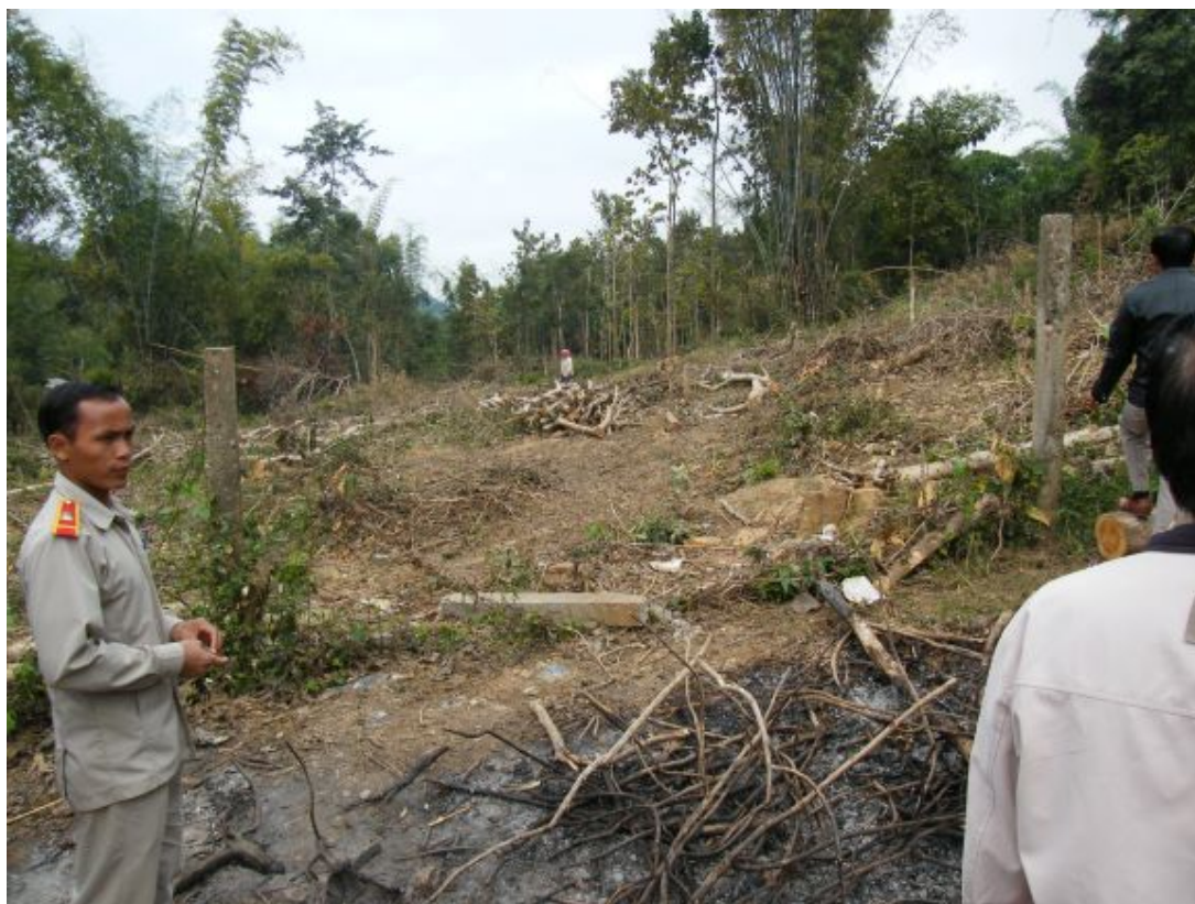
Avant les travaux, le site où sera installée l'aire de sport
