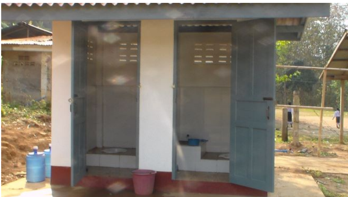
Latrines carrelés avec réserve d'eau, portes fermant de l'intérieur
