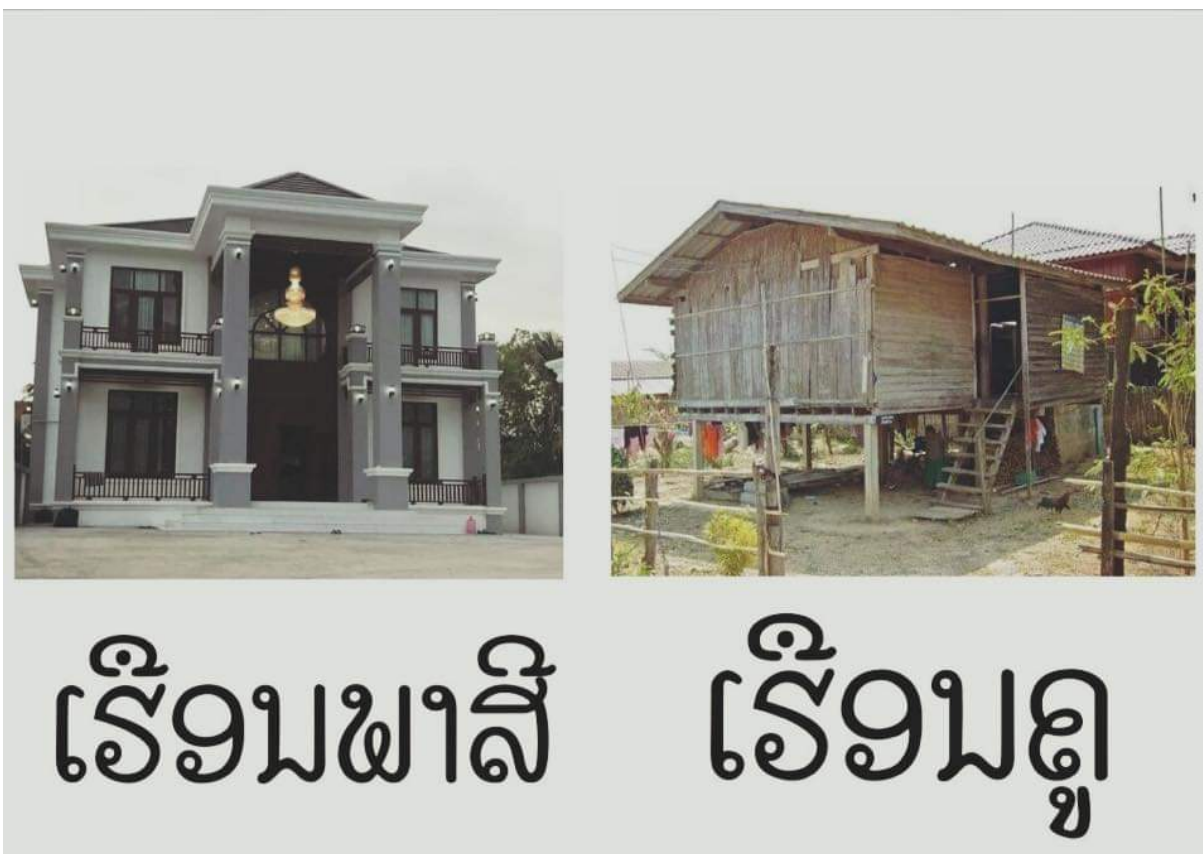
A gauche la maison d'un douanier.
