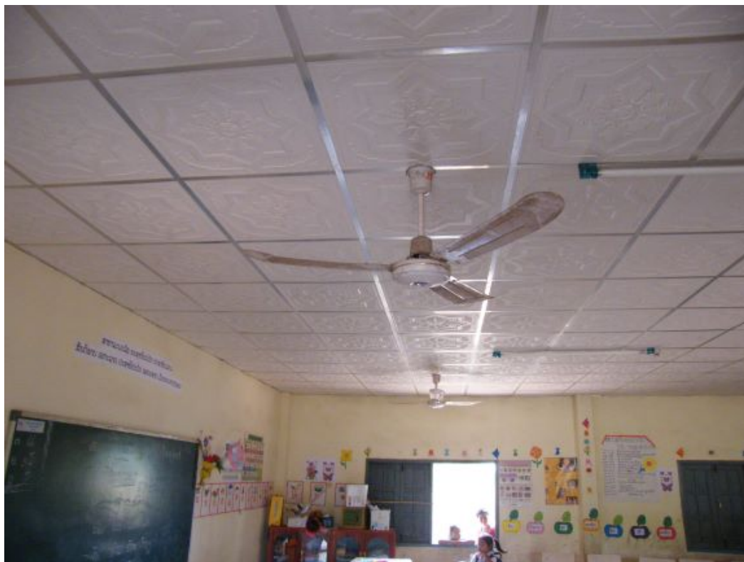
Les faux plafonds sont posés
