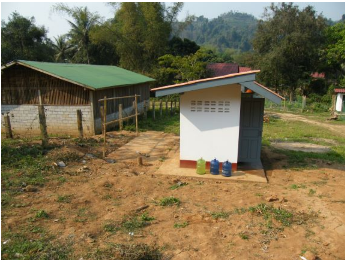
Le bâtiment de latrines avec derrière une grande fosse septique enterrée
