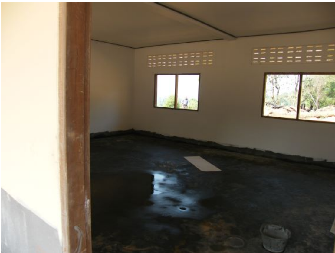
Dans un des deux nouveaux bâtiments une salle de classe en construction
