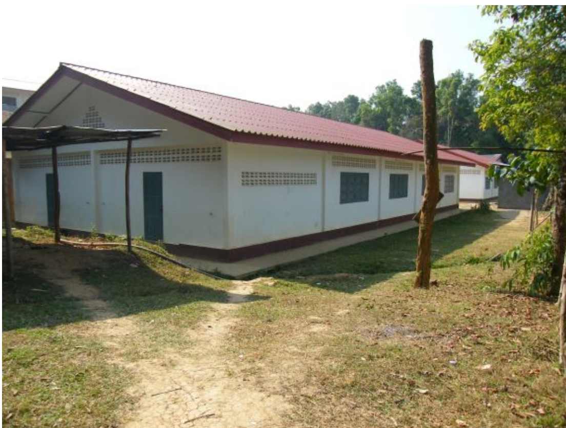
Les deux bâtiments de dortoir inutilisés
