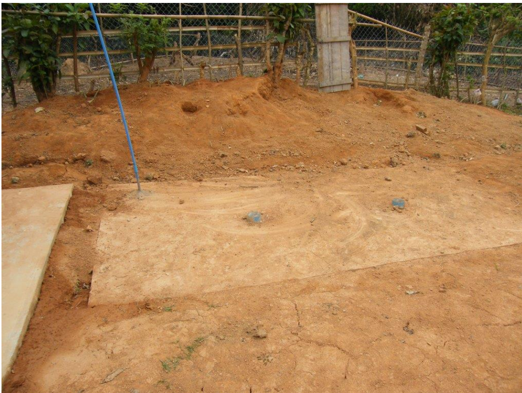
Une grande fosse septique permet des rejets propres dans le rivière proche
