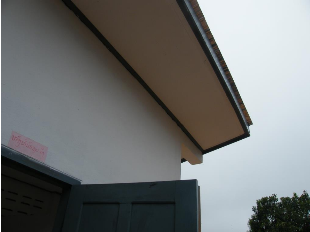
Des dessous de toit solides empêchent le vent, lors des tempêtes, de soulever les tôles
